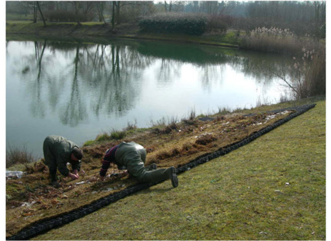
Assemblage des modules et mise en place des géonattes coco pré-végétalisées sur la berge.
