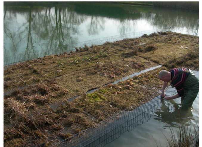
Mise à l'eau et installation du grillage de surface limitant l'impact des canards sur la végétation.
