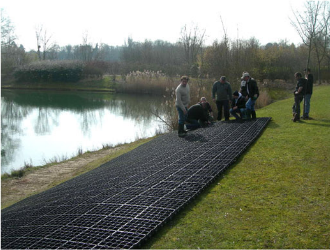
Assemblage des modules et mise en place des géonattes coco pré-végétalisées sur la berge.
