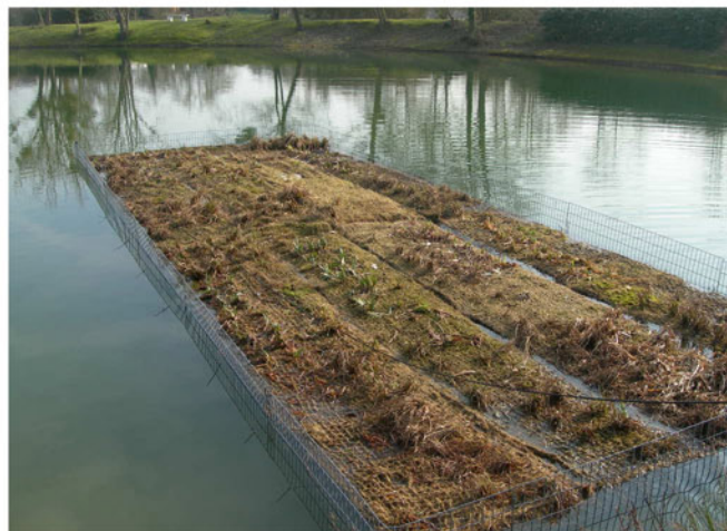
Mise à l'eau et installation du grillage de surface limitant l'impact des canards sur la végétation.
