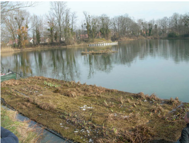
Mise à l'eau et installation du grillage de surface limitant l'impact des canards sur la végétation.
