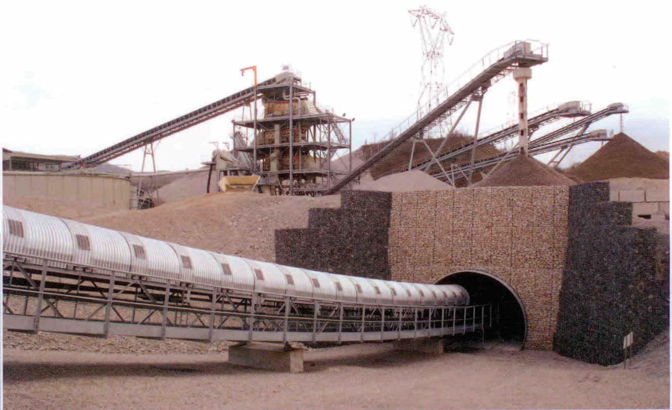
Réf. 0504 - Gabions Uni-Gabions mis en œuvre à la carrière Budillon Rabatel, sur l'installation réservée au lavage
